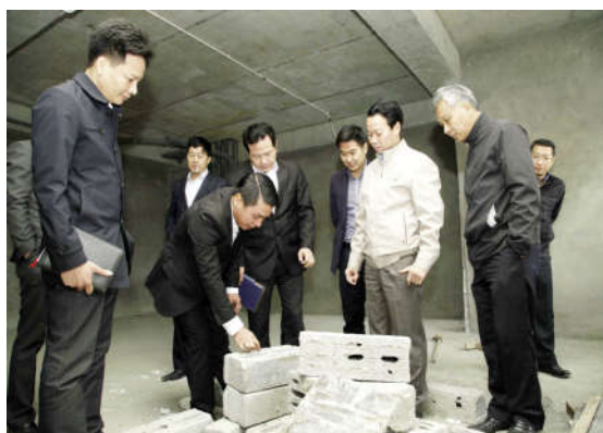
Thứ trưởng Đỗ Đức Duy và đoàn khảo sát của Bộ Xây dựng tại hiện trường
